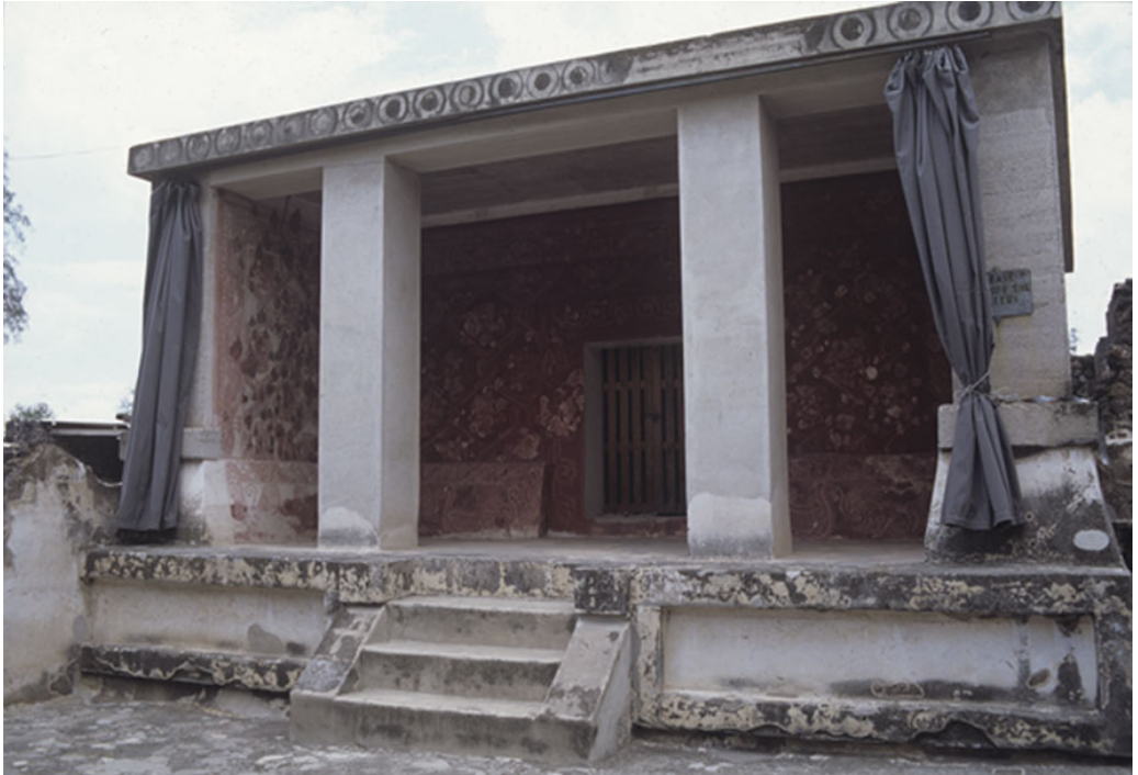
Figura 1. Estado de México, Teotihuacán. Patio Blanco. Pórtico 2. Foto Leticia Staines Cicero, 1996.
